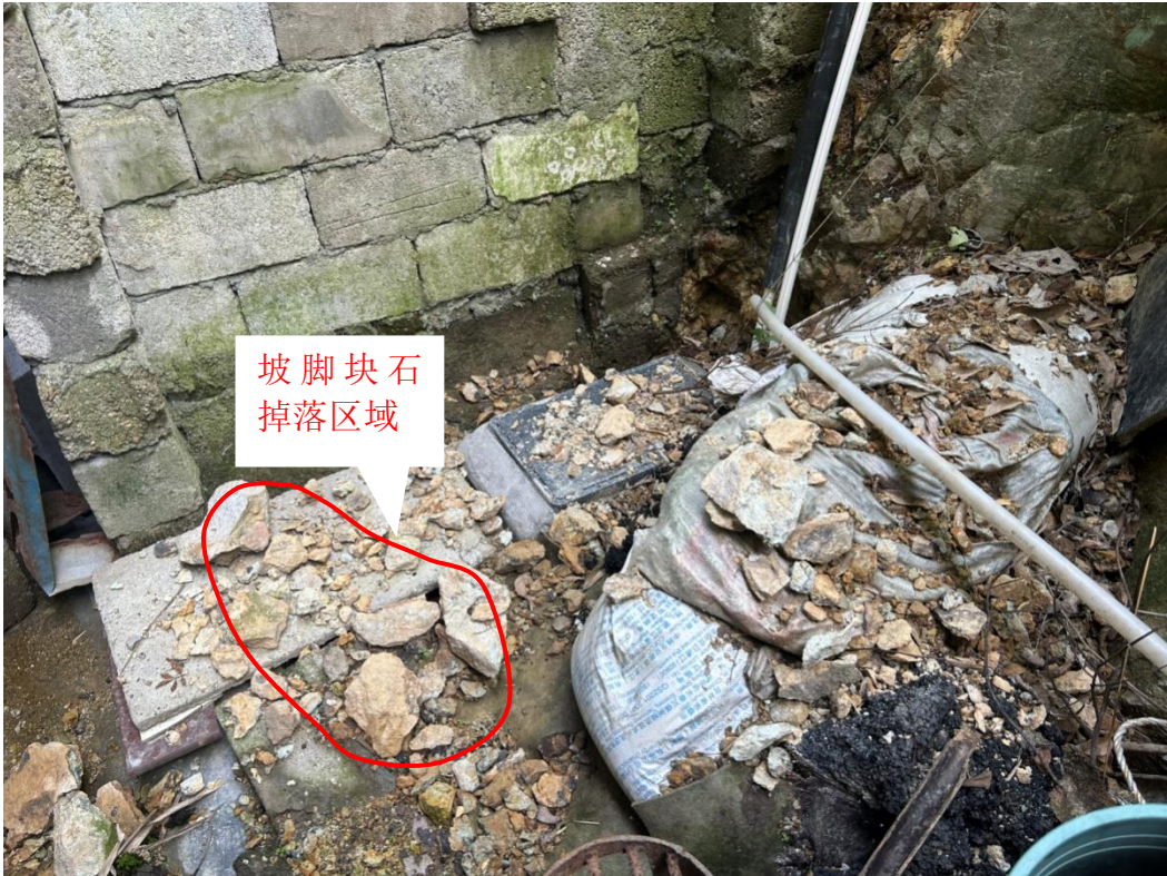
照片 11 勘察区 II 段边坡坡脚块石掉落照片位于地质调查点 D6 附近(镜向西)
