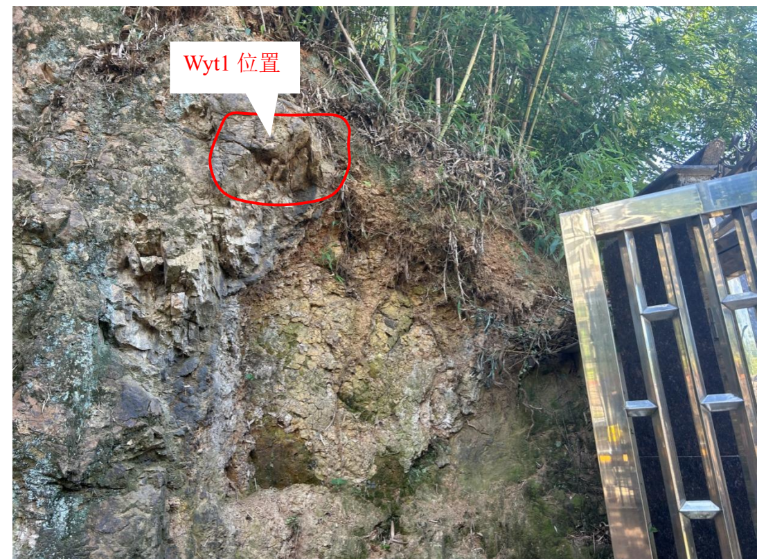
照片 7 勘查区 I 段边坡危岩体 1 照片位于地质调查点 D3 附近(镜向东北)
