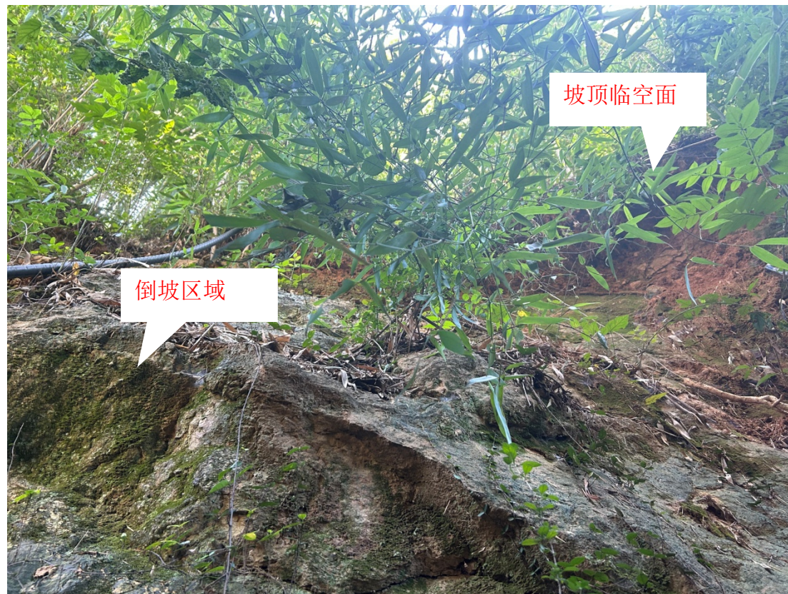
照片 4 勘查区 I 段边坡坡顶临空面及倒坡照片位于地质调查点 D2、D4 附近(镜向东)
