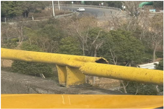
图 19 第 2 联护栏钢扶手错位
