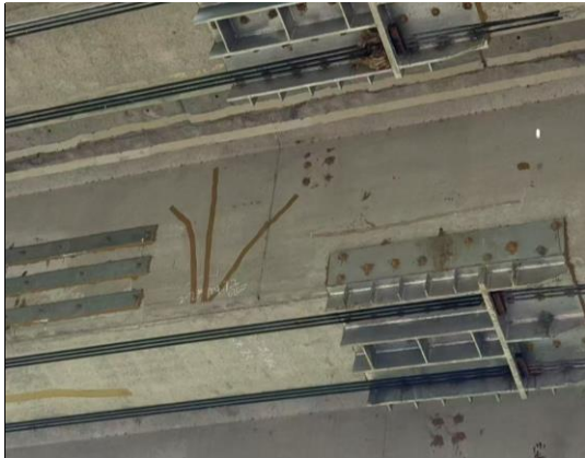
图 5 加固后梁底照
