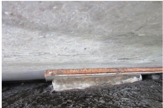
图 13 11-10-12# 支座剪切变形
