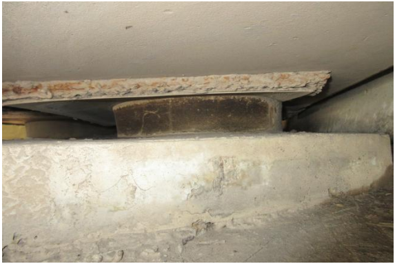
图 29 23-22-8#支座剪切变形、位移
