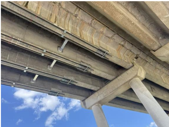
图 4 加固后梁底照
