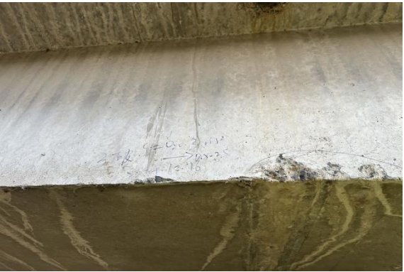
图 23 3-9#板梁露筋
